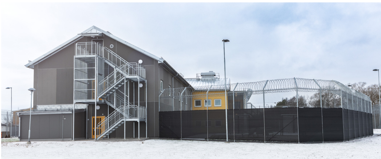
För Kriminalvården har Specialfastigheter senaste åren uppfört ett stort antal typhus – generellt utformade husmodeller som ska klara certifiering enligt lägst nivå Miljöbyggnad Silver och kan byggas på flera fastigheter runt om i landet.
