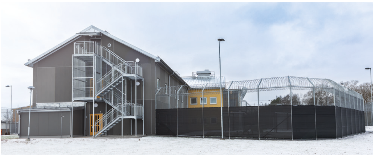
För Kriminalvården har Specialfastigheter senaste åren uppfört ett stort antal typhus – generellt utformade husmodeller som ska klara certifiering enligt lägst nivå Miljöbyggnad Silver och kan byggas på flera fastigheter runt om i landet.
